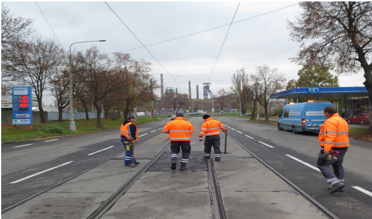
B12 - Bahník u sjezdu k ČSAD - hloubka odtoku 1,15m.
