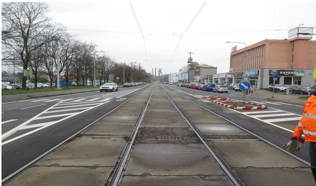
B03 - Bahník za křižovatkou Vítkovická / TIETO / spojka ÚAN - hloubka odtoku 1,10m.
