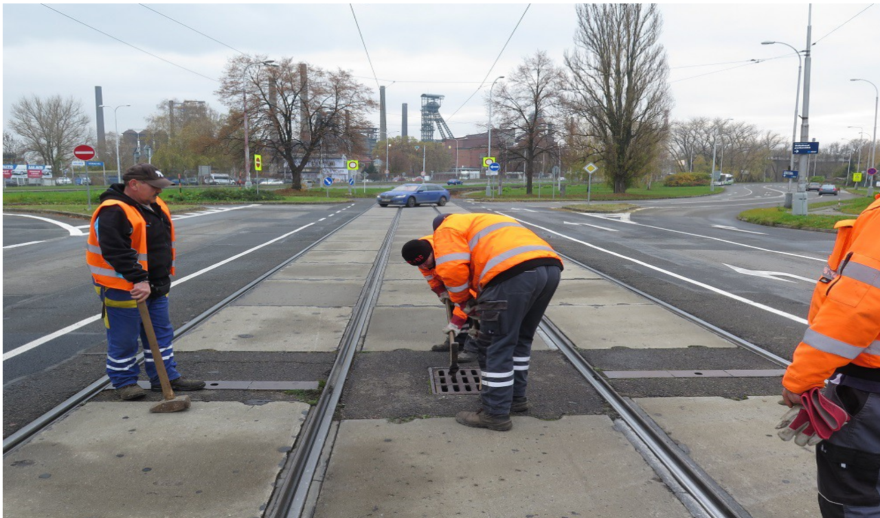
B13 - Bahník před křižovatkou Vítkovická / Železárenská / Místecká - hloubka odtoku 1,70m.
