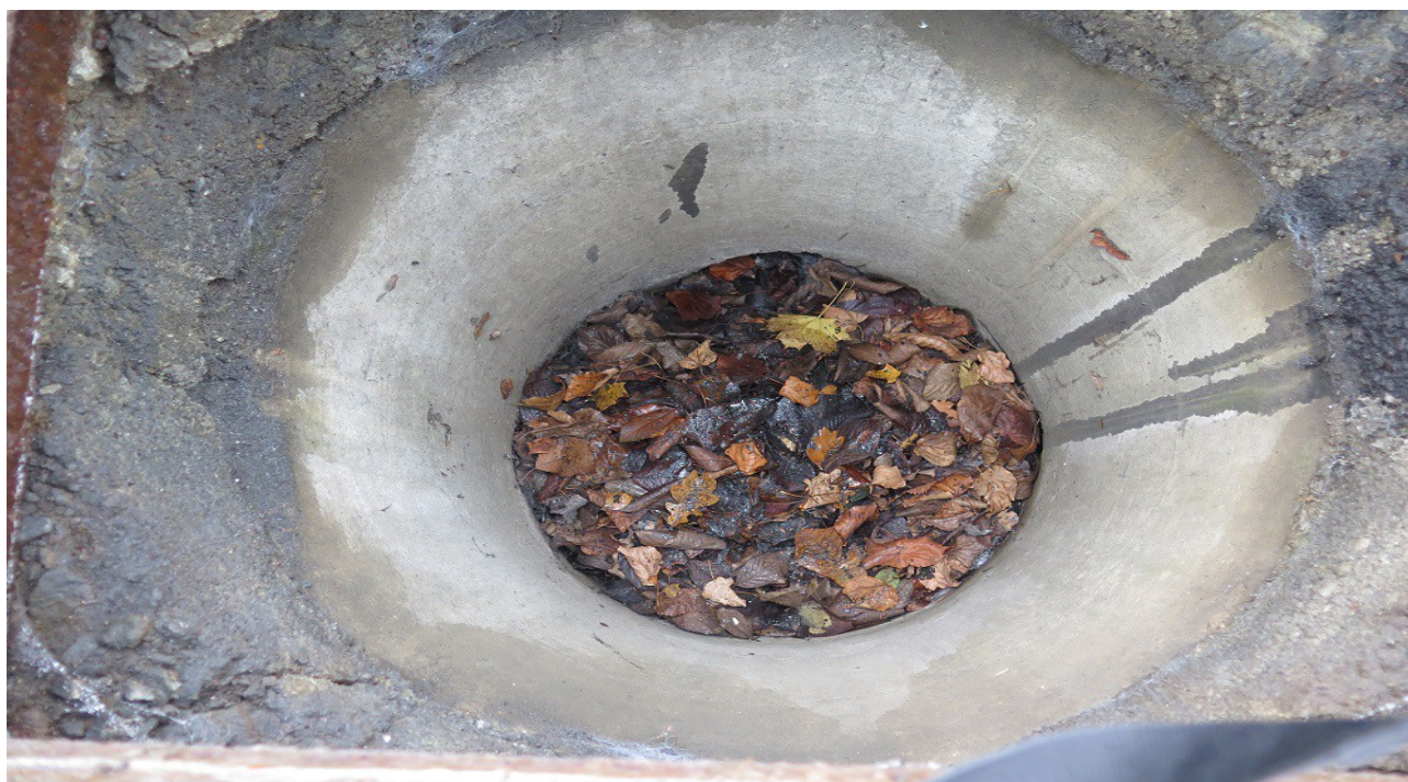
B02 - Bahník před křižovatkou Vítkovická / TIETO / spojka ÚAN - hloubka odtoku 1,20m.
