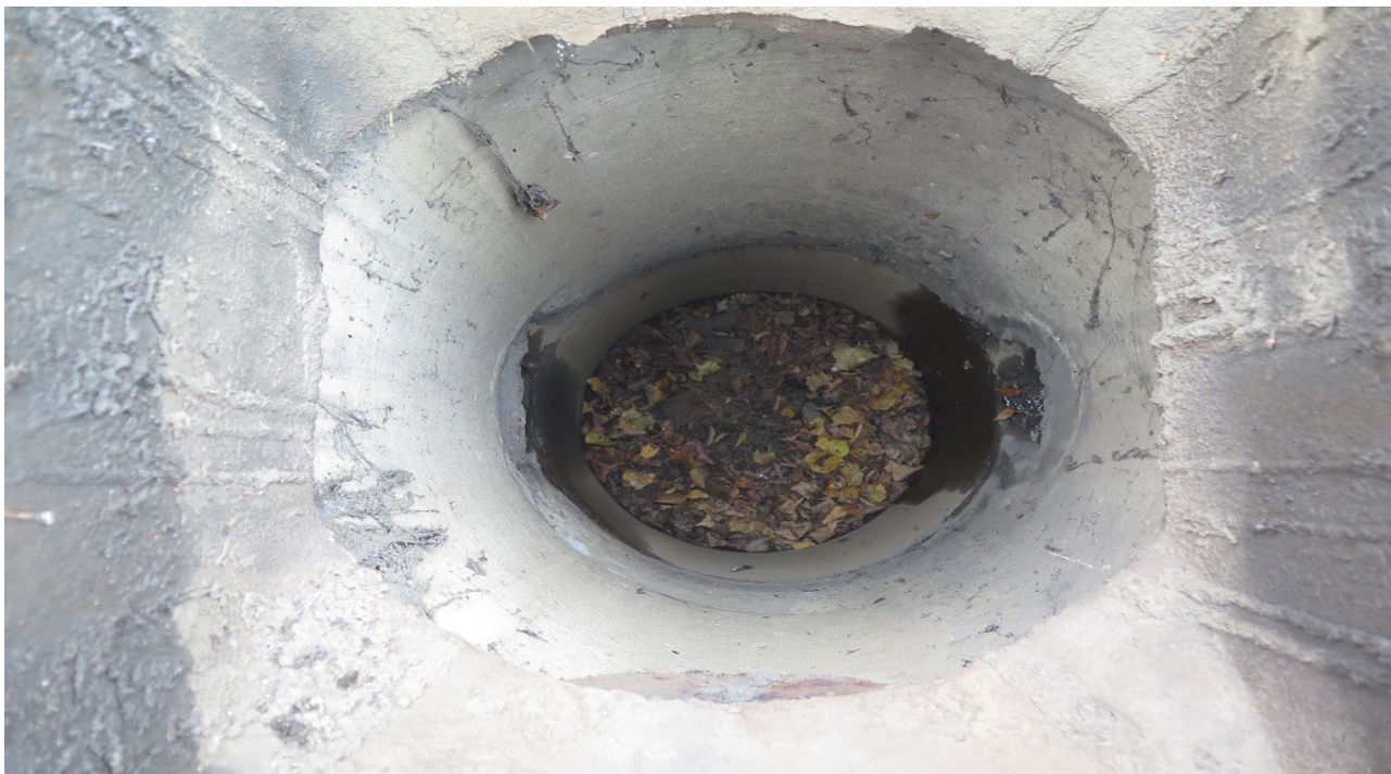
B13 - Bahník před křižovatkou Vítkovická / Železárenská / Místecká - hloubka odtoku 1,70m.
