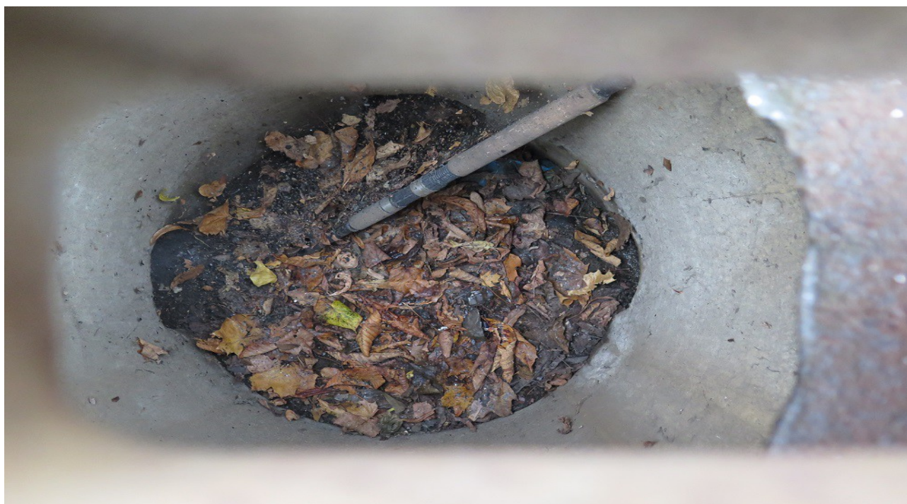
B04 - Bahník u katastrálního úřadu - hloubka odtoku 1,00m.
