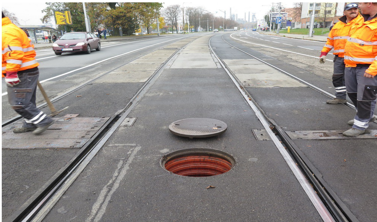
B01 - Bahník za křižovatkou Vítkovická / 28.října (u kolejových k-cí) - hloubka odtoku 0,76m.
