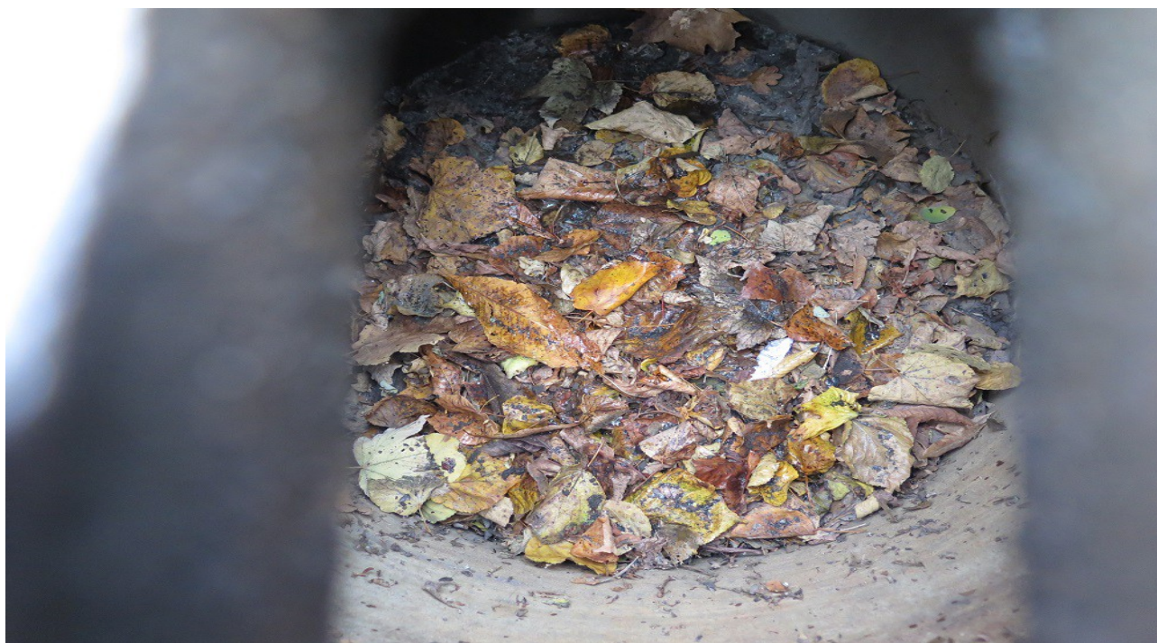
B07 - Bahník za křižovatku Vítkovická / Dr.Malého / spojka MÚK - hloubka 0,70m (zanesený).
