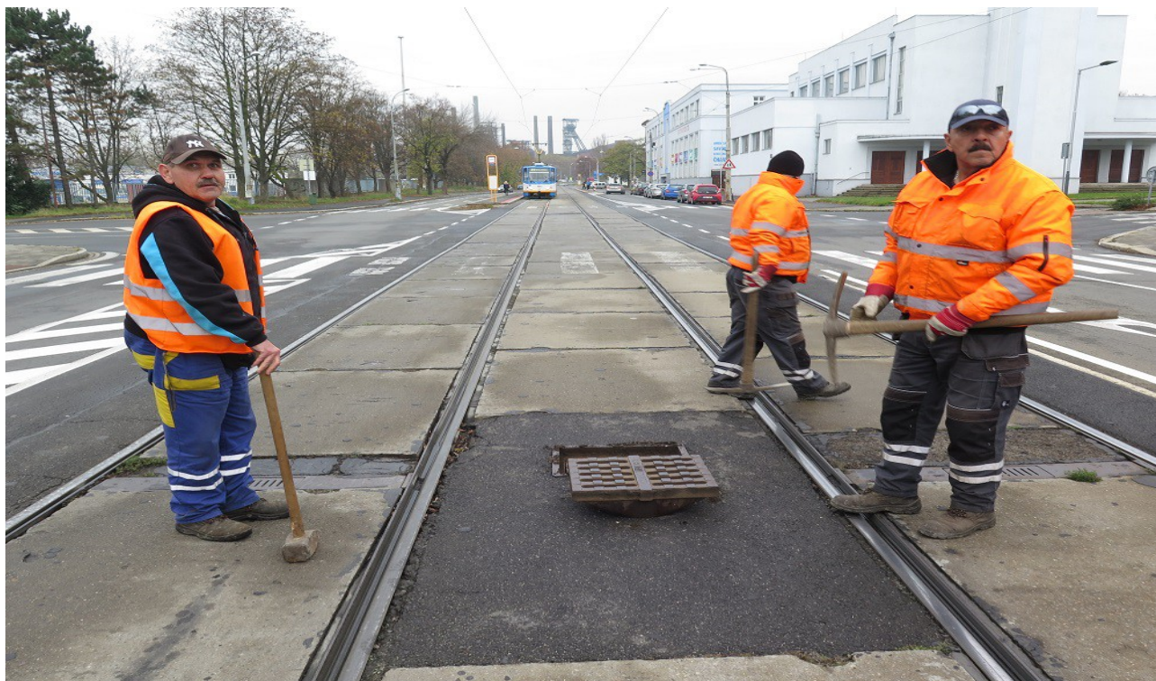
B06 - Bahník před křižovatkou Vítkovická / Dr.Malého / spojka MÚK - hloubka odtoku 1,20m.
