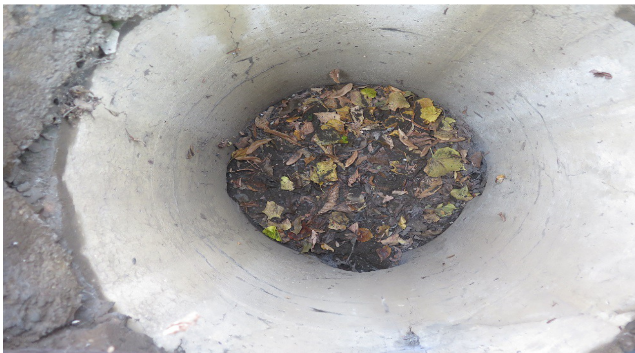
B06 - Bahník před křižovatkou Vítkovická / Dr.Malého / spojka MÚK - hloubka odtoku 1,20m.
