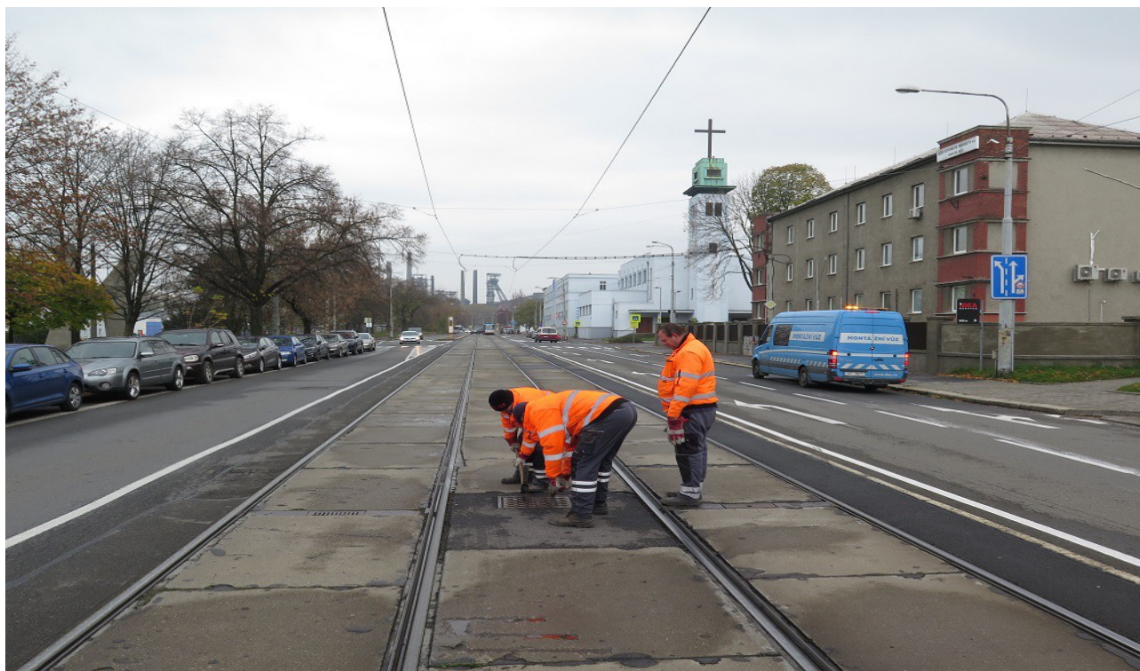
B05 - Bahník u polyfunkčního domu - hloubka odtoku 1,10m.
