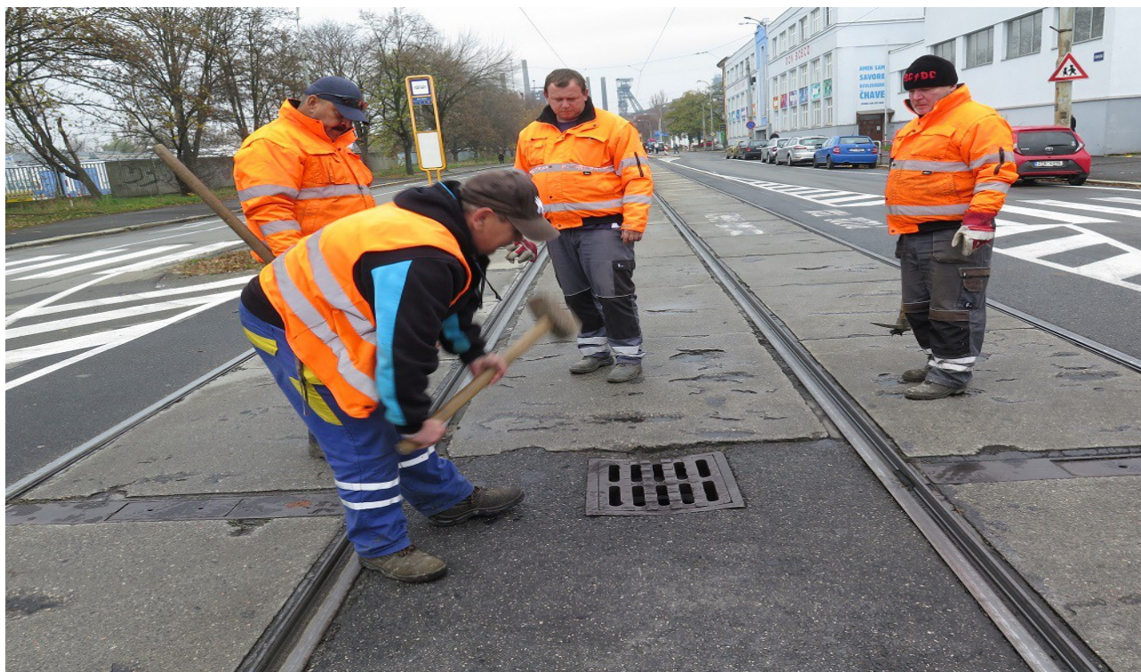
B07 - Bahník za křižovatku Vítkovická / Dr.Malého / spojka MÚK - hloubka 0,70m (zanesený).
