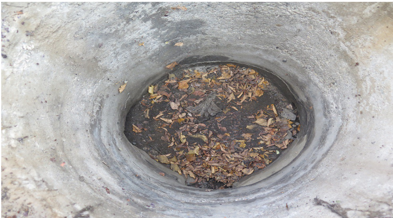
B12 - Bahník u sjezdu k ČSAD - hloubka odtoku 1,15m.
