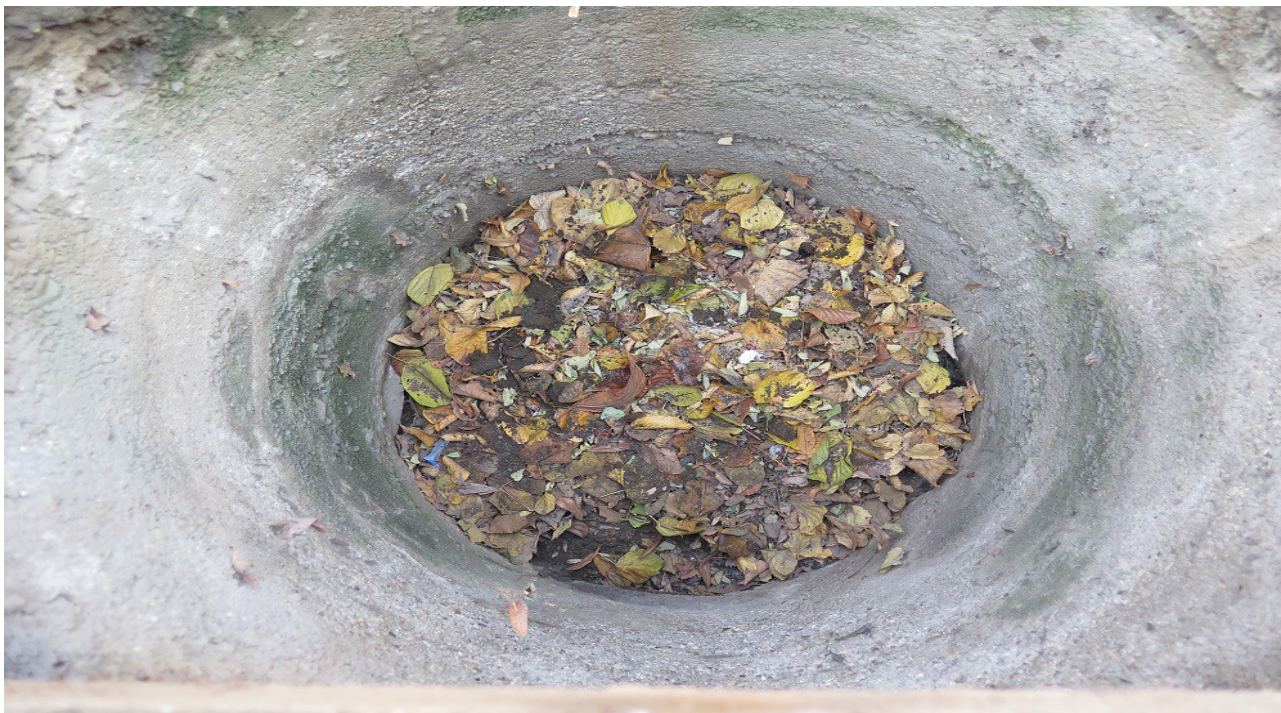
B10 - Bahník před křižovatkou vítkovická / Gajdošova - hloubka odtoku 1,10m.
