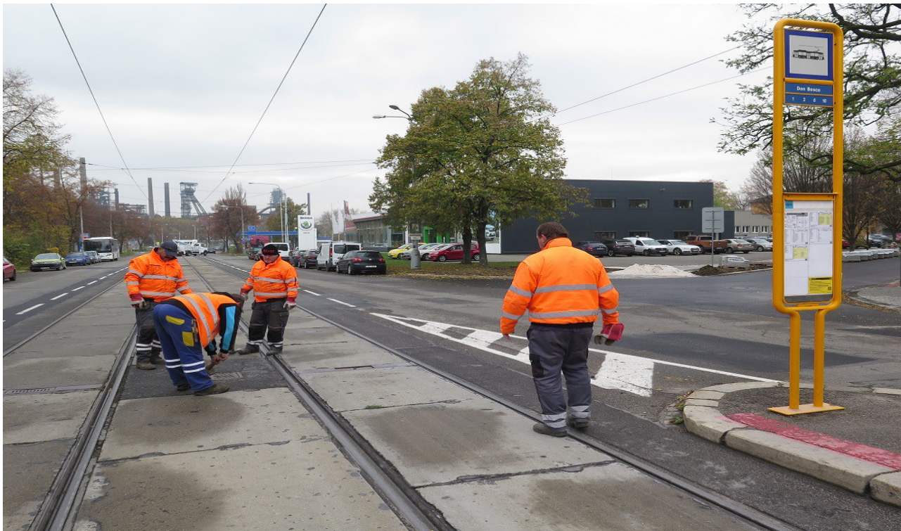
B10 - Bahník před křižovatkou vítkovická / Gajdošova - hloubka odtoku 1,10m.
