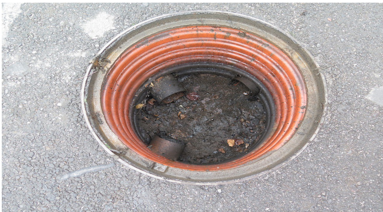
B01 - Bahník za křižovatkou Vítkovická / 28.října (u kolejových k-cí) - hloubka odtoku 0,76m.
