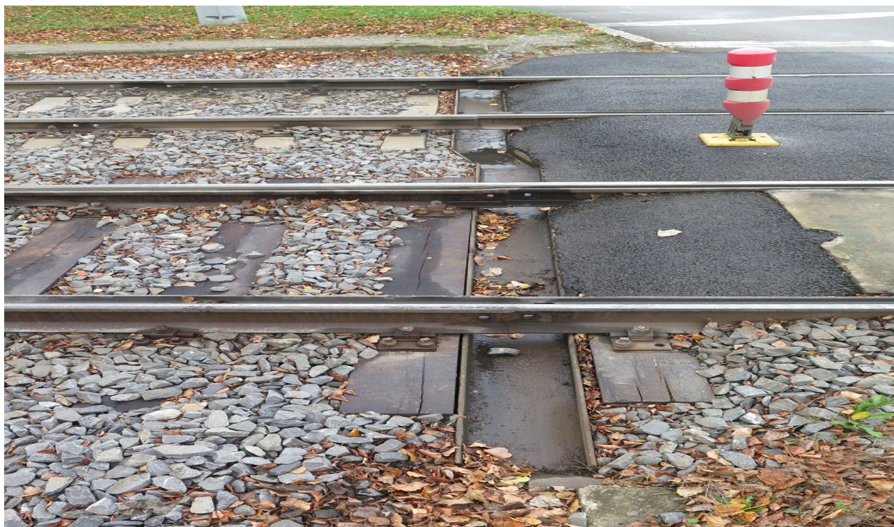
B14 - Odvodňovací žlab za křižovatkou Vítkovická / Železárenská - začátek segregované TT.
